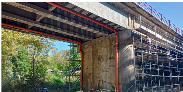
Αποκατάσταση φορέων και βάθρων της γέφυρας του Ποταμού Νέστου επί της Εθνικής Οδού Δράμα - Παρανέστι
