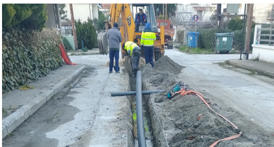
Αντικατάσταση εσωτερικού δικτύου ύδρευσης στον οικισμό Κεραμωτής
