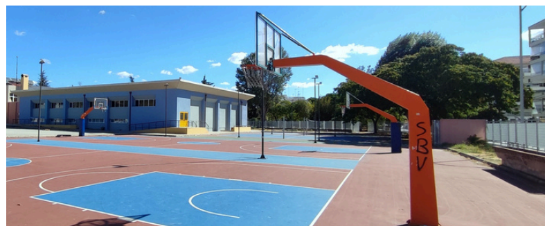
Λειτουργική αναβάθμιση αύλειων χώρων των διδακτηρίων του Δήμου Κομοτηνής
