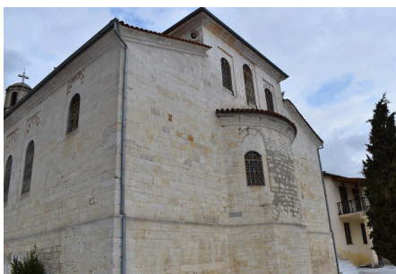
Αποκατάσταση μεταβυζαντινού Ναού Αγίου Γεωργίου Σουφλίου
