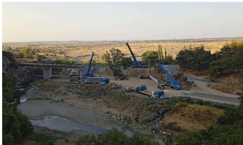
Αποκατάσταση γέφυρας ποταμού Κομφάτου
