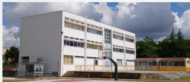
Ενεργειακή αναβάθμιση και αξιοποίηση ανανεώσιμων πηγών ενέργειας - 4ο Δημοτικό Σχολείο Χρυσούπολης
