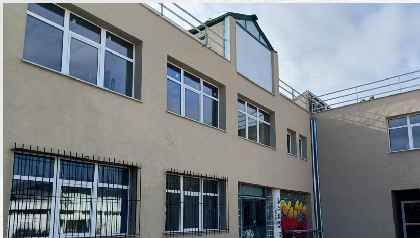
Ενεργειακή αναβάθμιση κτιρίου βιβλιοθήκης ΔΠΘ στην Καβάλα
