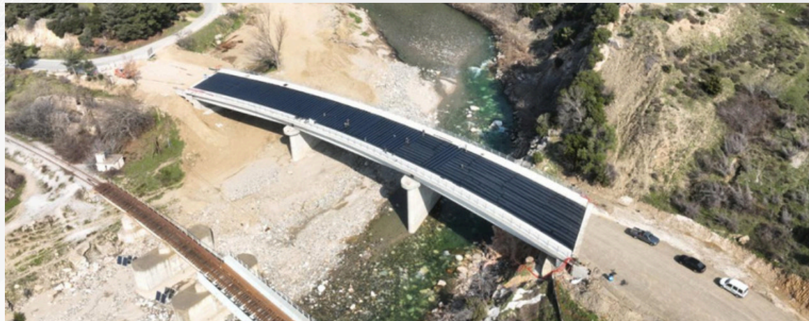
Αποκατάσταση γέφυρας ποταμού Κομφάτου
