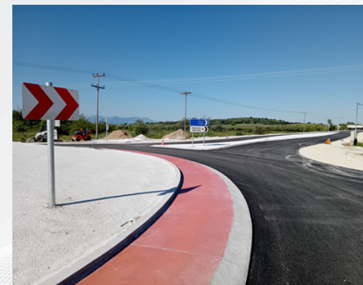
Κατασκευή κυκλικών κόμβων στην αρ. 9 Οδό (Κόμβος Μαγγάνων – Κόμβος Αβδήρων)
