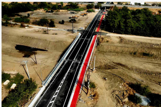
Κατασκευή γέφυρας Κοσμίου και ποδηλατόδρομου από Ραδιοφωνικό Σταθμό έως Κόσμο
