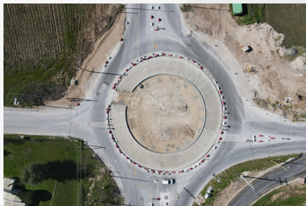
Ανακατασκευή του κόμβου στη ΒΙ.ΠΕ Δράμας και μετατροπή του σε κυκλικό
